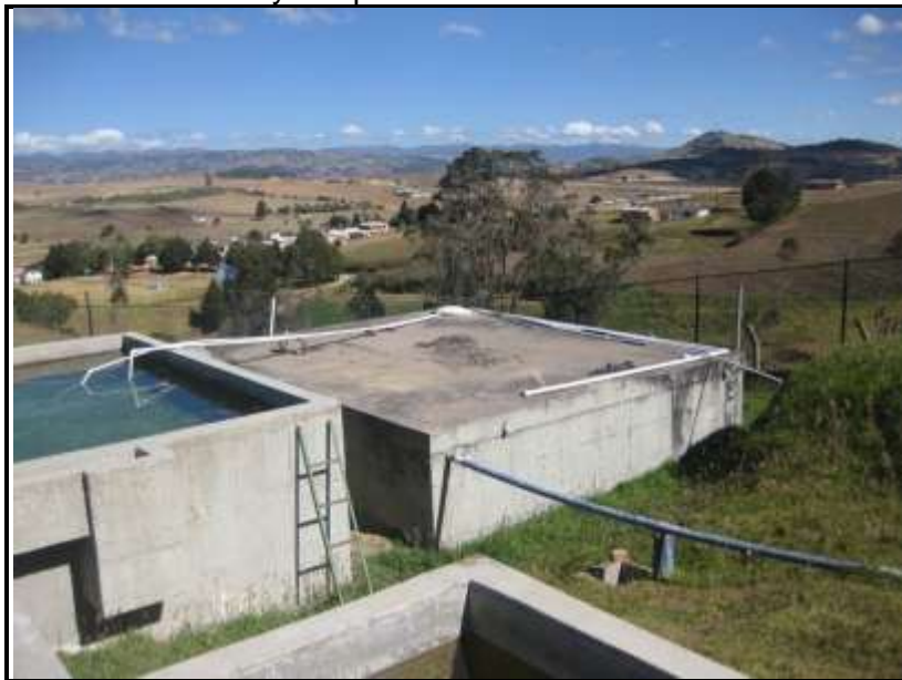
Grafico 14. Filtro lento en arena y tanque de almacenamiento.
