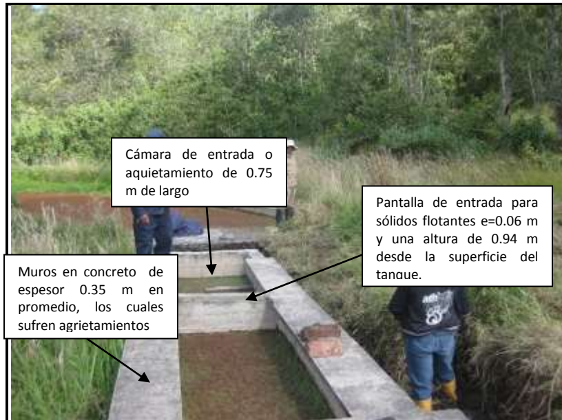
Grafico 7. Vista frontal del desarenador
