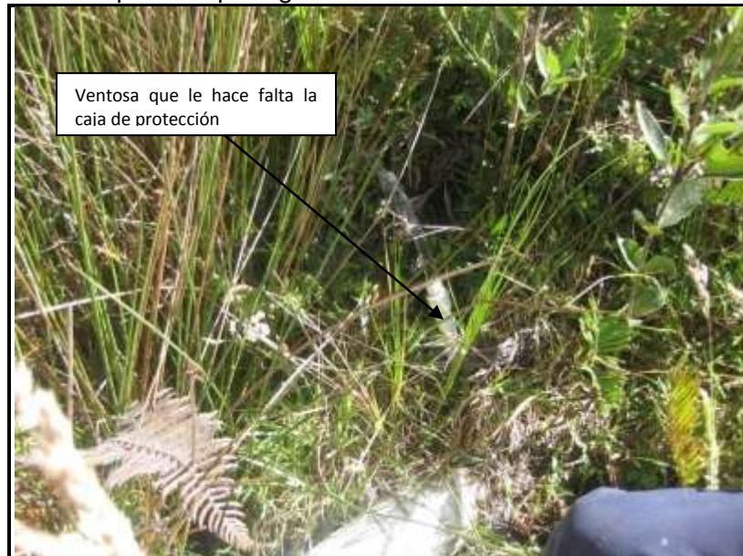
Grafico 22. Accesorio que falta protegerlos N: 1098101 E: 1083547.
