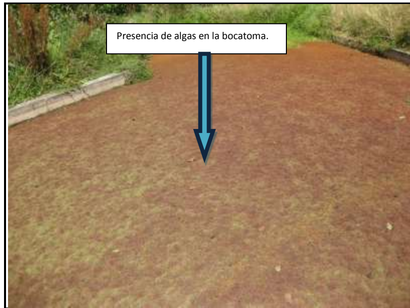
Grafico 17. Eutrofización del agua por la presencia de algas en el desarenador y bocatoma
